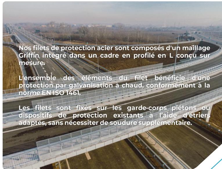
Nos filets de protection acier sont composés d'un maillage Griffin intégré dans un cadre en profilé en L conçu sur mesure.
