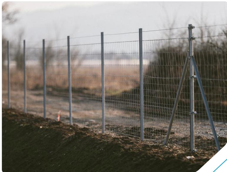
Nous proposons des fils avec différentes hauteurs et types de maillage, adaptés à divers besoins. Nous offrons également une solution avec des **supports ancrés directement dans le sol**, éliminant ainsi la nécessité de massifs en béton.
